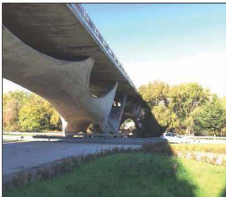
Un particolare del ponte Musmeci
